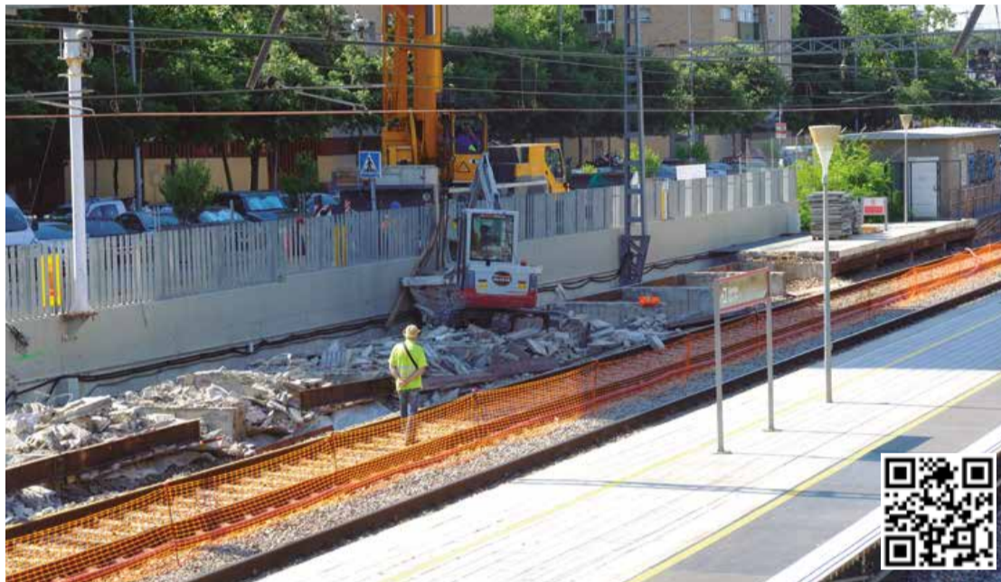
Obras en la estación de Bellvitge-Gornal el pasado 22 de mayo
