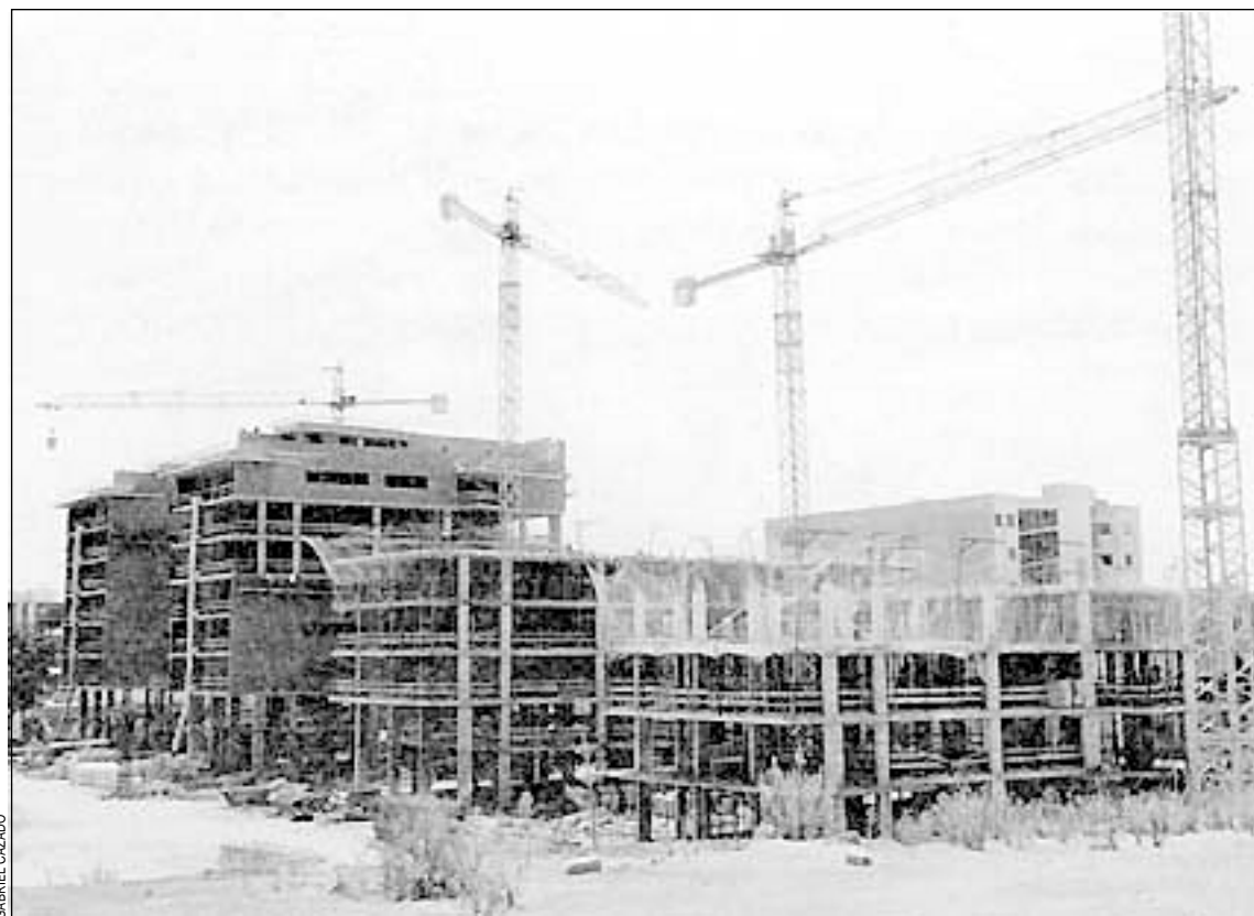
Obras del PERI Tecla Sala, de planificación municipal y ejecución privada
