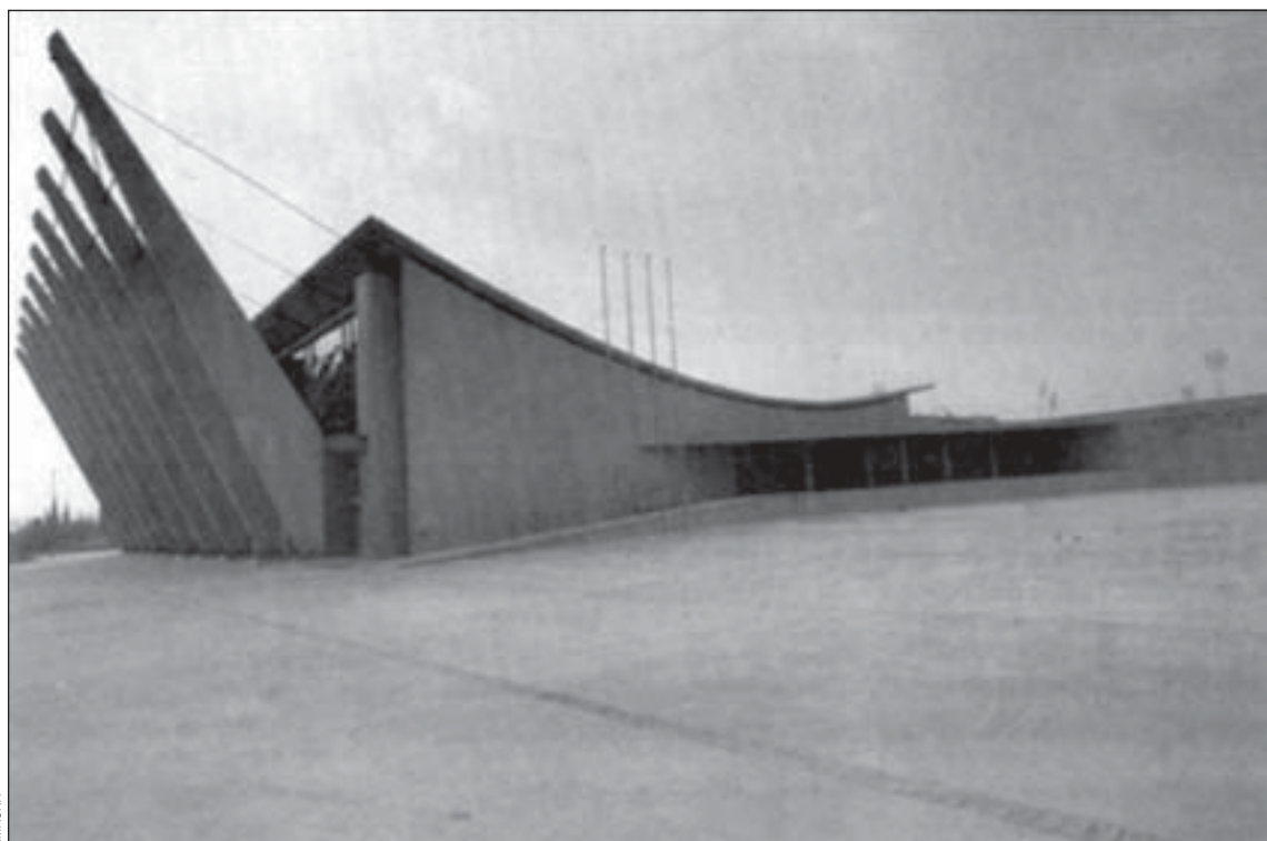
Aspecto exterior del nuevo polideportivo, con sus característicos pilares de contrapeso
