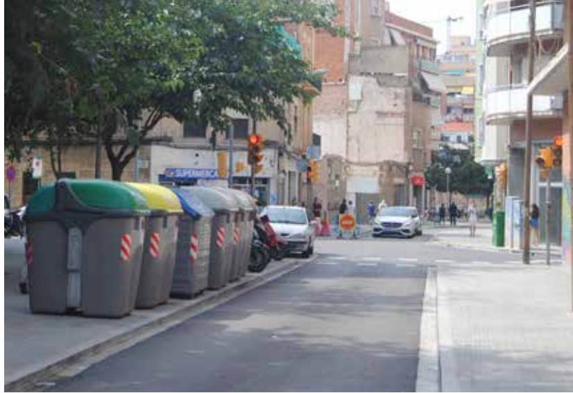
Aspecto del tramo de la calle Aprestadora una vez remodelada
