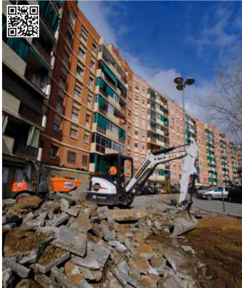
Obras de remodelación en la calle Clavells
