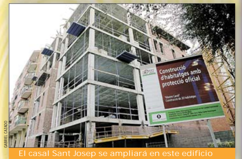
El casal Sant Josep se ampliará en este edificio
