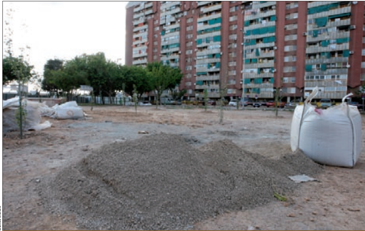
Movimiento de tierras en el solar donde se ubicará la residencia
