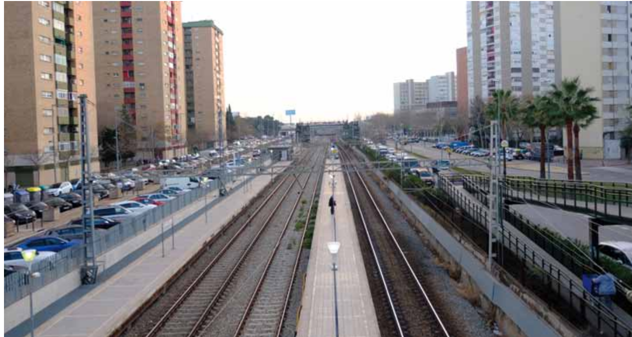
La vía férrea de Vilanova divide los barrios de Bellvitge y Gornal
