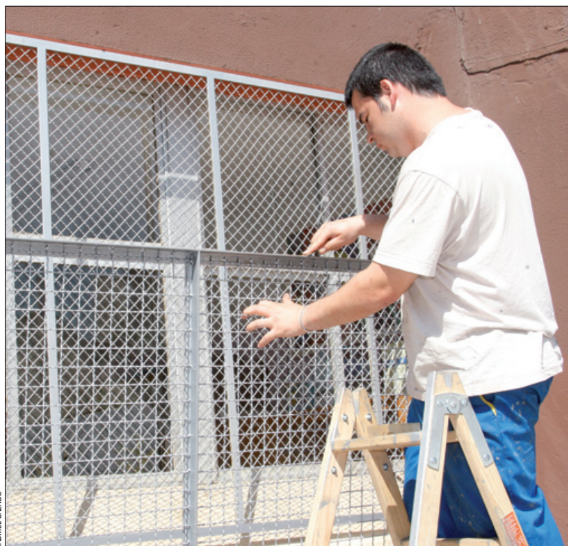
Obras en el CEIP Josep Janés
