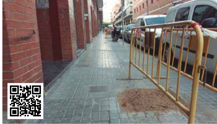
Escocells buits al carrer de Bacardí de Santa Eulàlia
