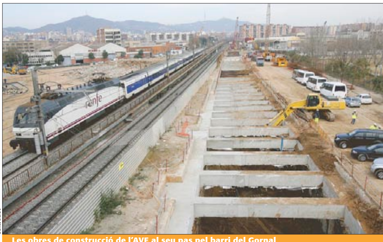
Les obres de construcció de l'AVE al seu pas pel barri del Gornal
