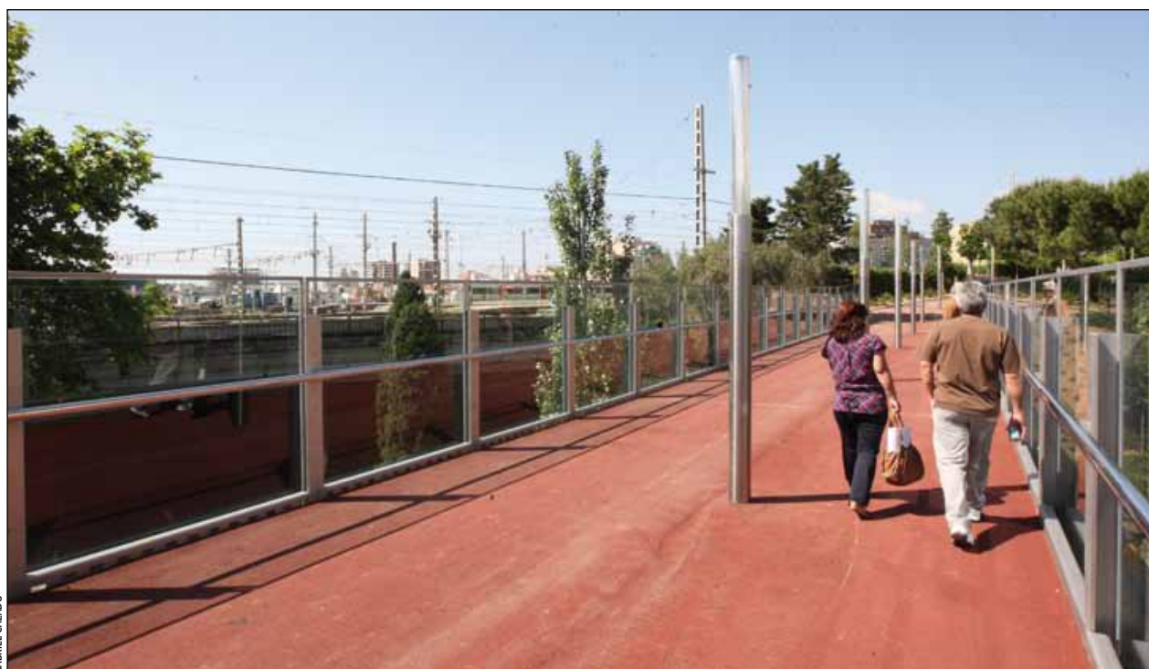
La passarel·la que uneix els parcs de les Planes i Can Cluset està oberta al públic
