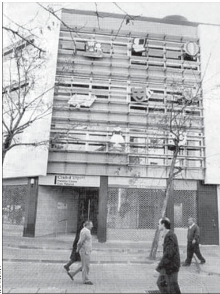
Sobre este edificio se construirá la biblioteca de La Bòbila
