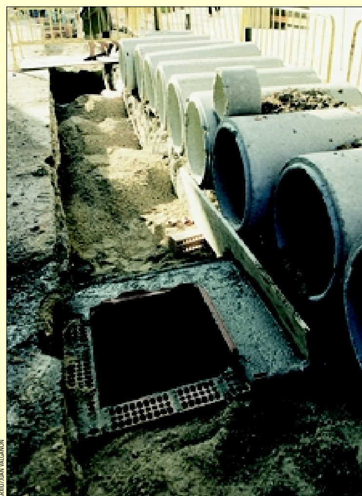
Reforma de la red de alcantarillado urbana
